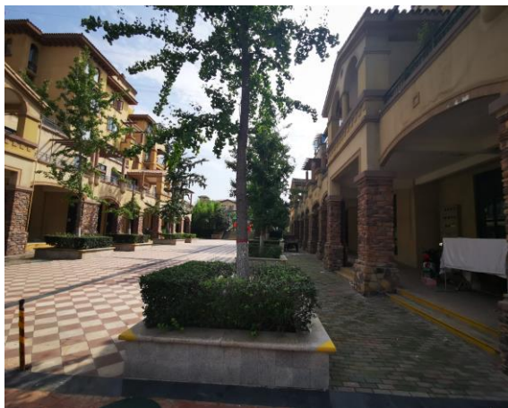
1 号院透水砖铺装
