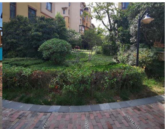
3 号院景观绿化+透水铺装
