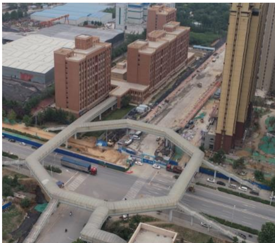
过街天桥现状
