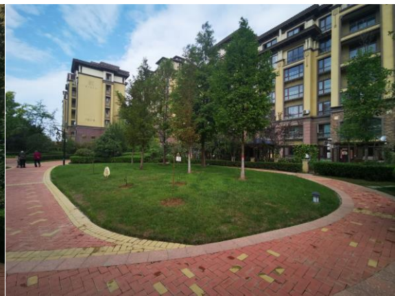
7 号院景观绿化+透水铺装
