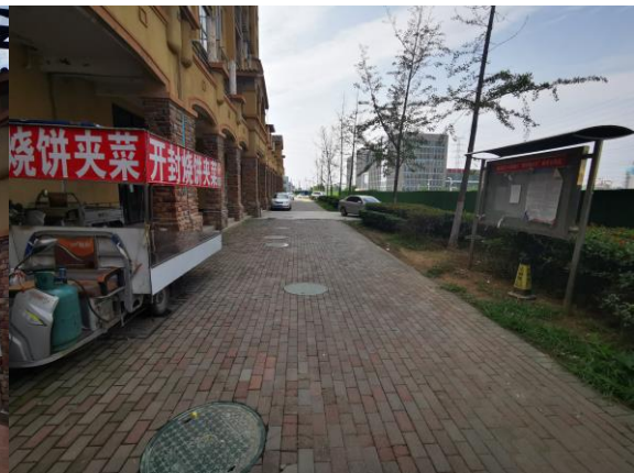
3 号院透水铺装+管网工程
