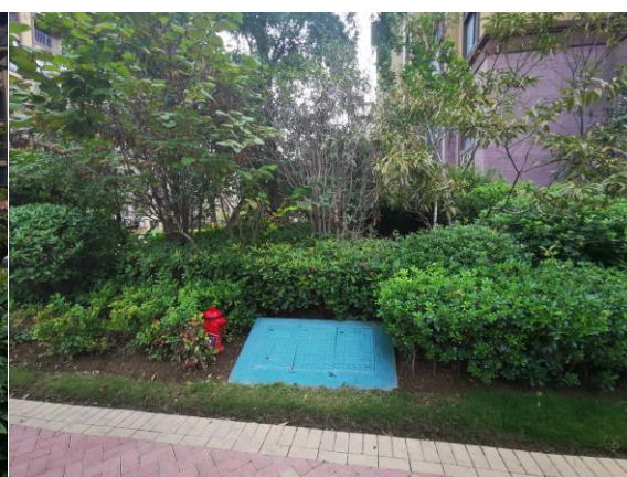
7 号院景观绿化+管网工程
