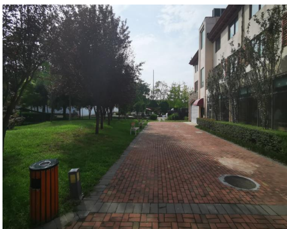
香堤湾温泉透水铺装+管网工程+绿化
