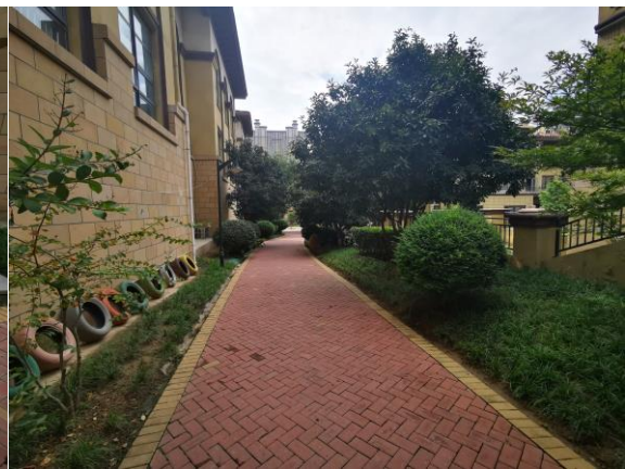
6 号院景观绿化+透水铺装
