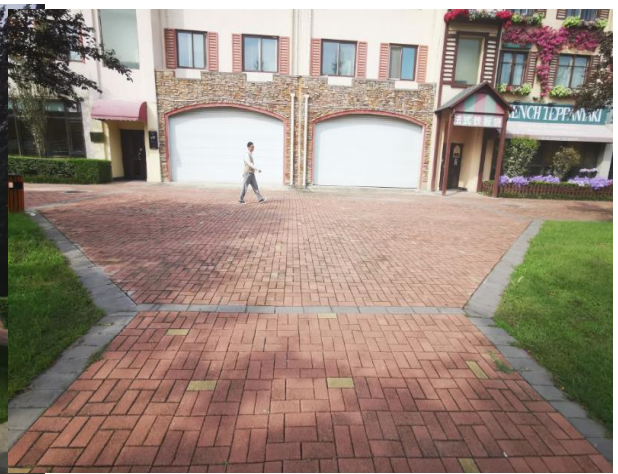
香堤湾温泉透水铺装
