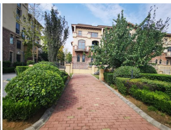
2 号院景观绿化+透水铺装
