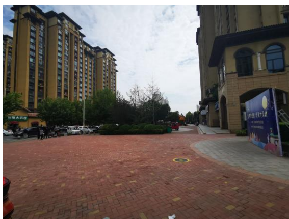
6 号院透水砖铺装
