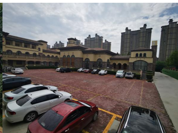
6 号院透水铺装
