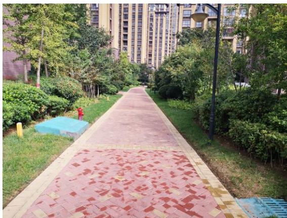
7 号院景观绿化+透水铺装+管网工程
